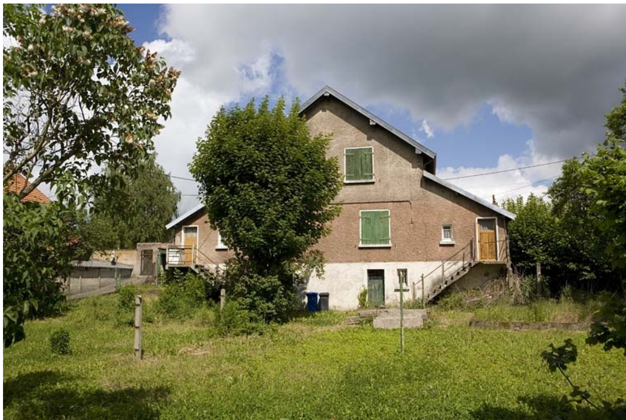
Cité Lehmann. Façade postérieure d'une maison.
