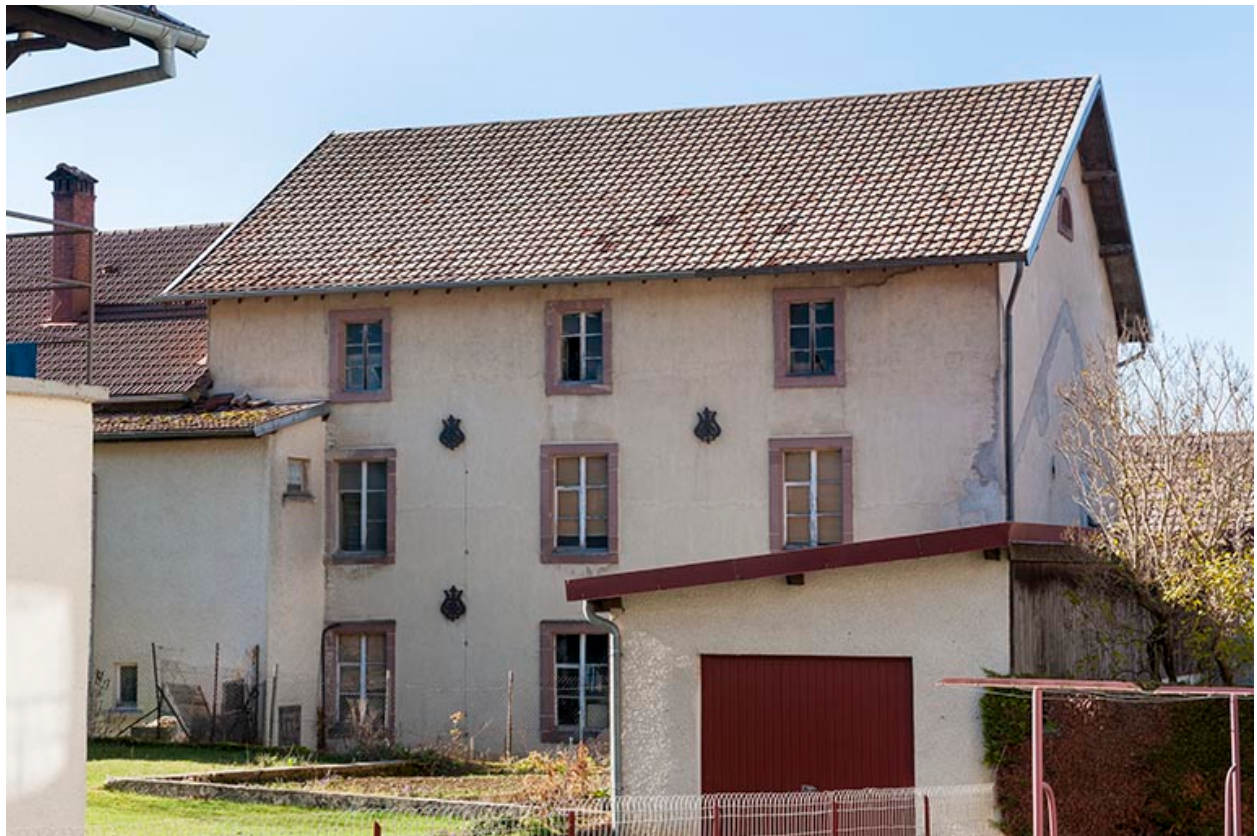
Minoterie : façade postérieure.
