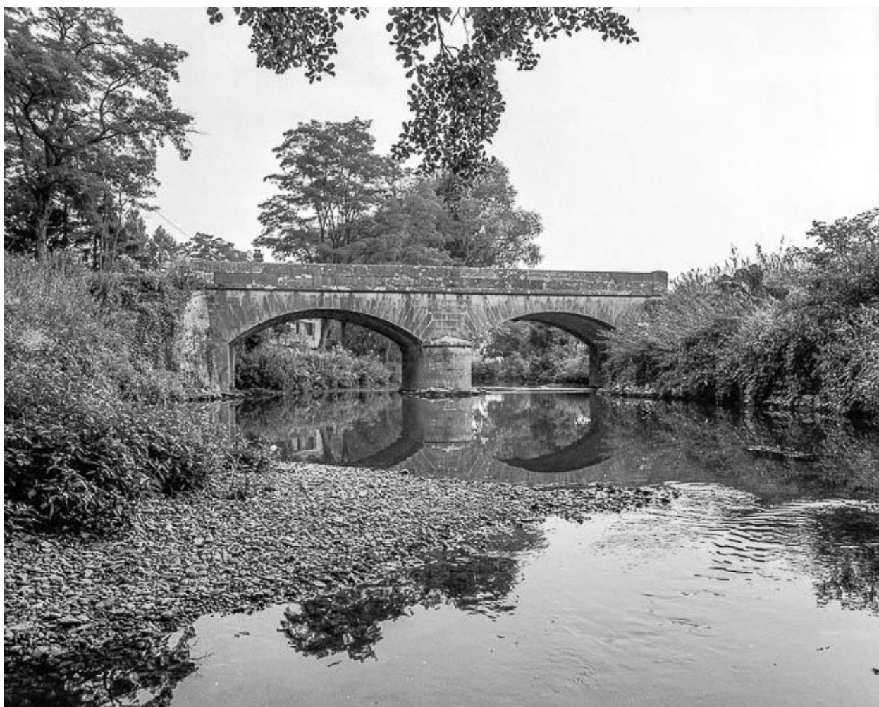
Condamine : pont sur la Vallière.
