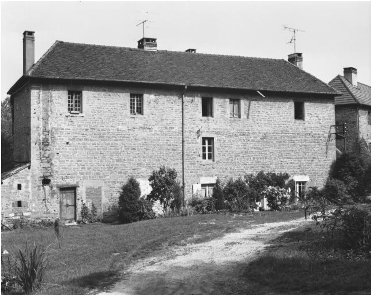
Façade antérieure d'un logement ouvrier.
