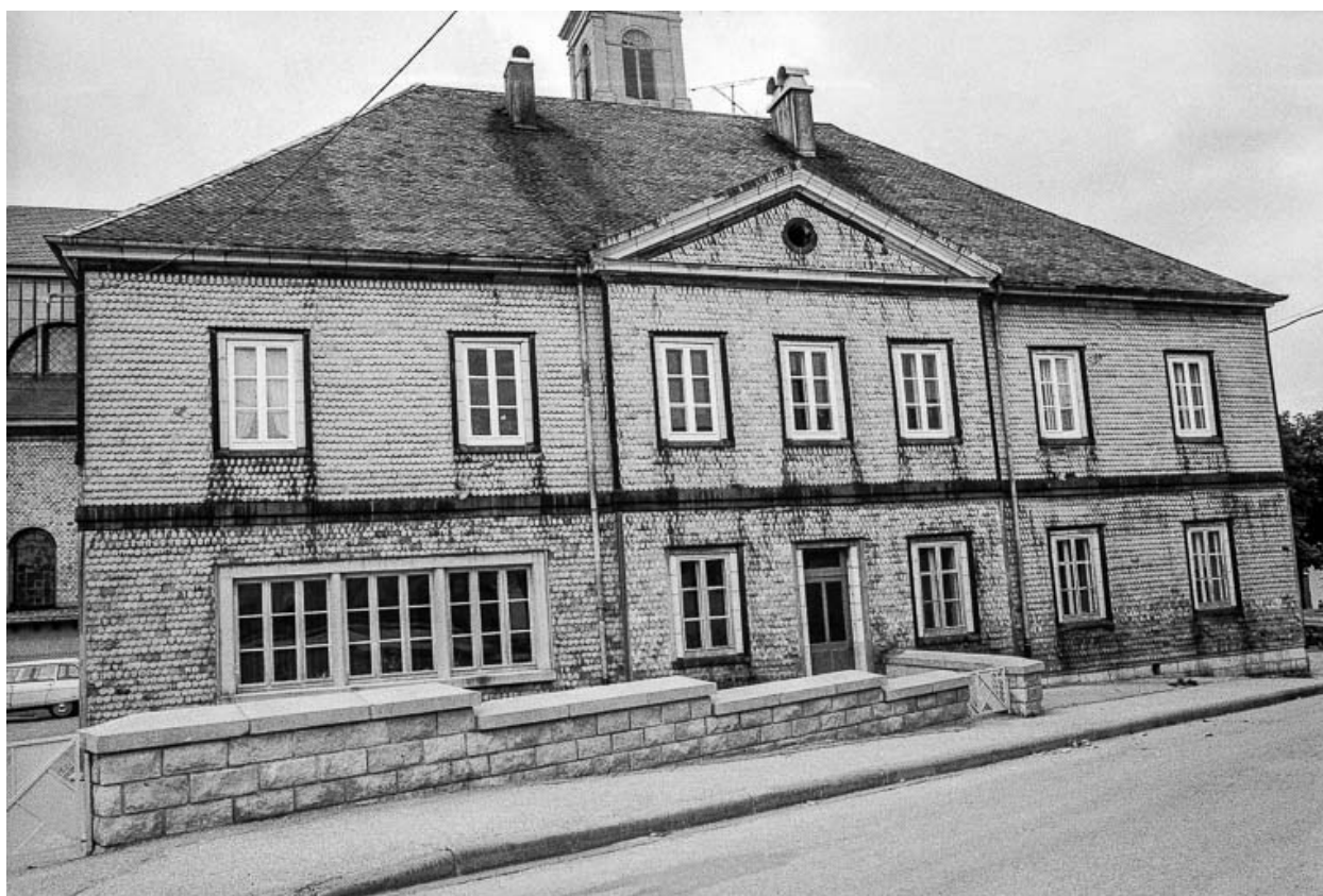
Ferme cadastrée 1975 F2 467, datée de 1854 : façade antérieure.
