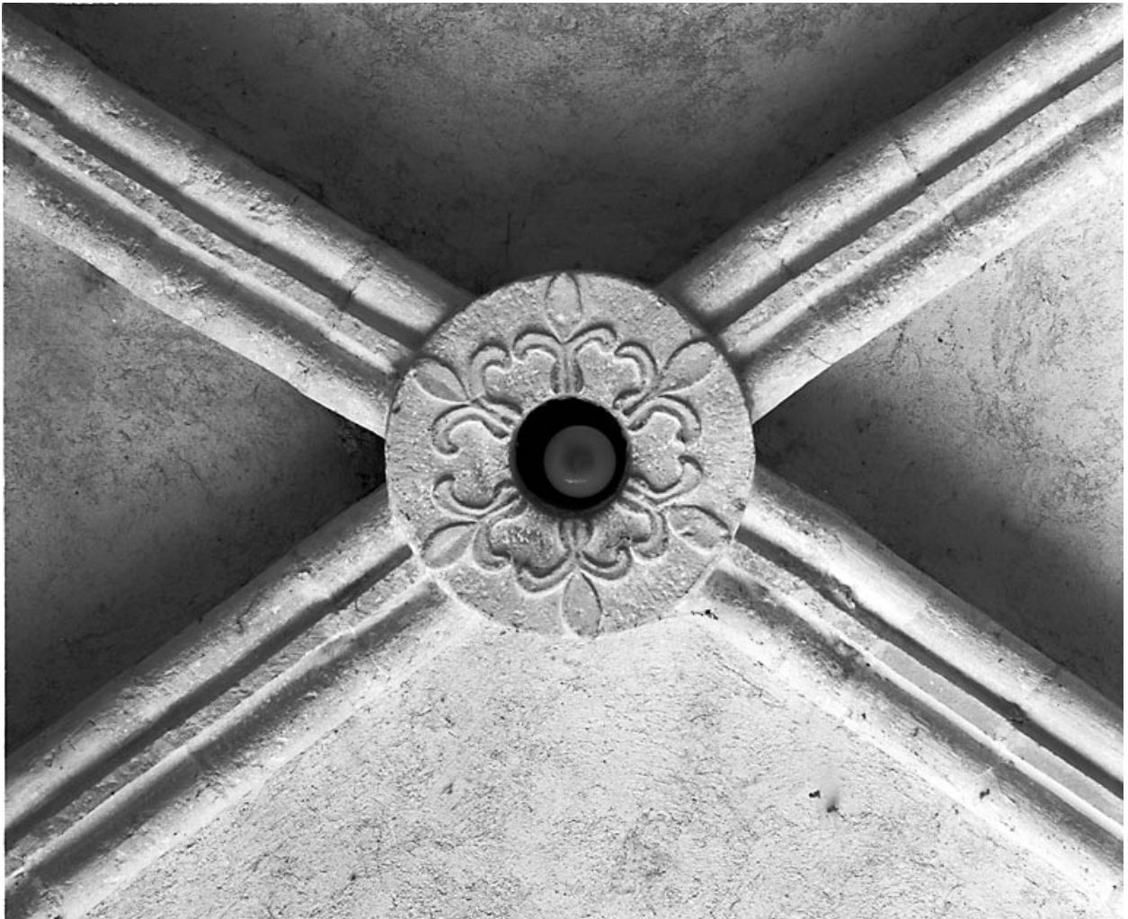
Eglise abbatiale : clef de voûte de 1ere travée du vaisseau central.
