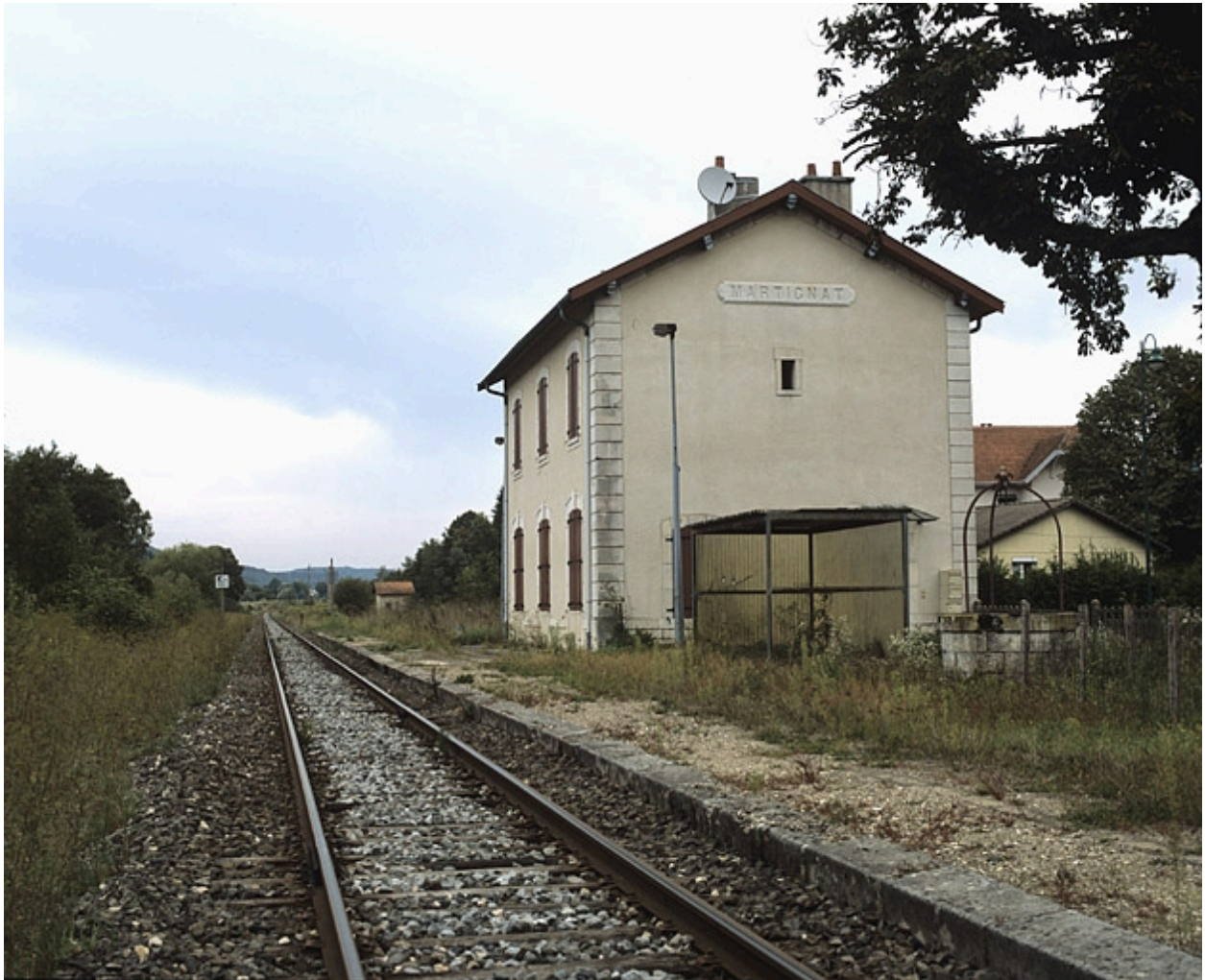
Façade postérieure, vue en enfilade depuis le côté La Cluse (sud-ouest).
