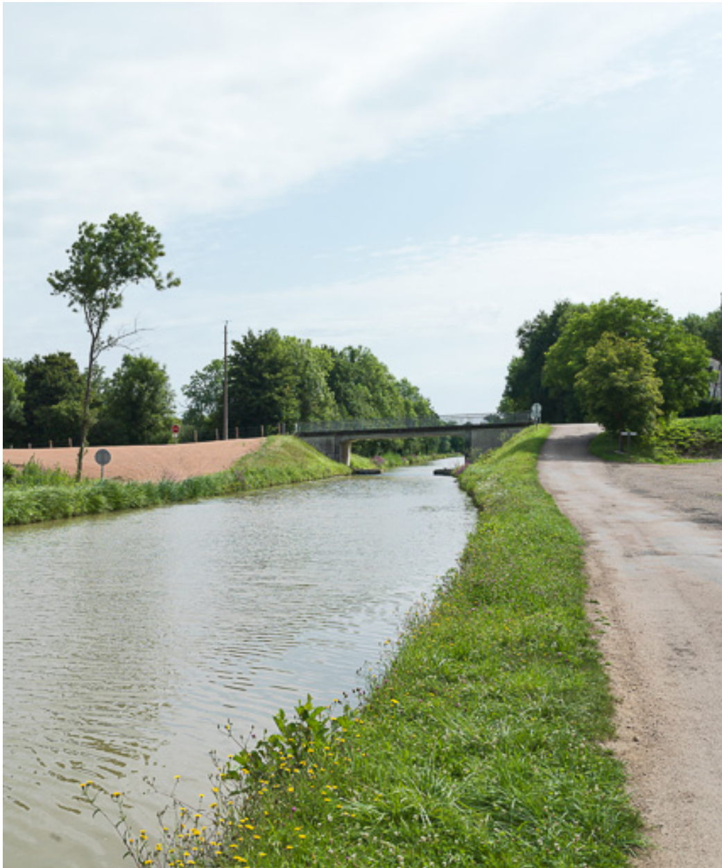
Vue d'ensemble du pont et du site.
