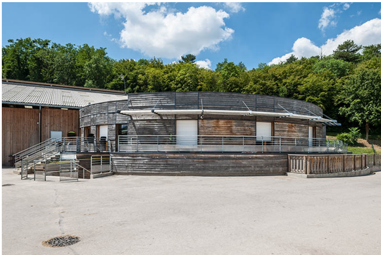
Centre équestre : rotonde du bâtiment d'accueil.
