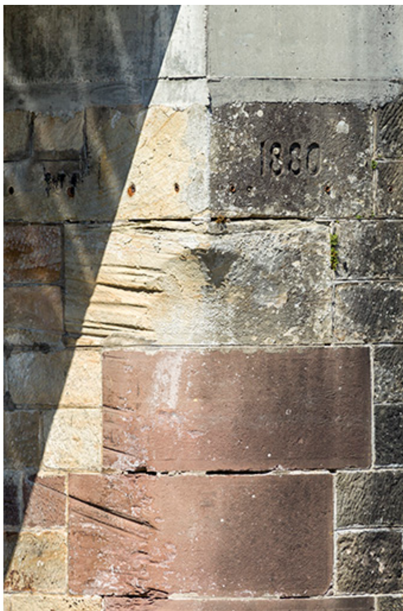
Détail des traces d'usure dans les maçonneries de l'écluse (aval) et date portée 1880.
