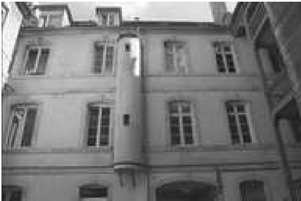
Hôtel et immeuble : façade postérieure du logis principal : détail des étages.
