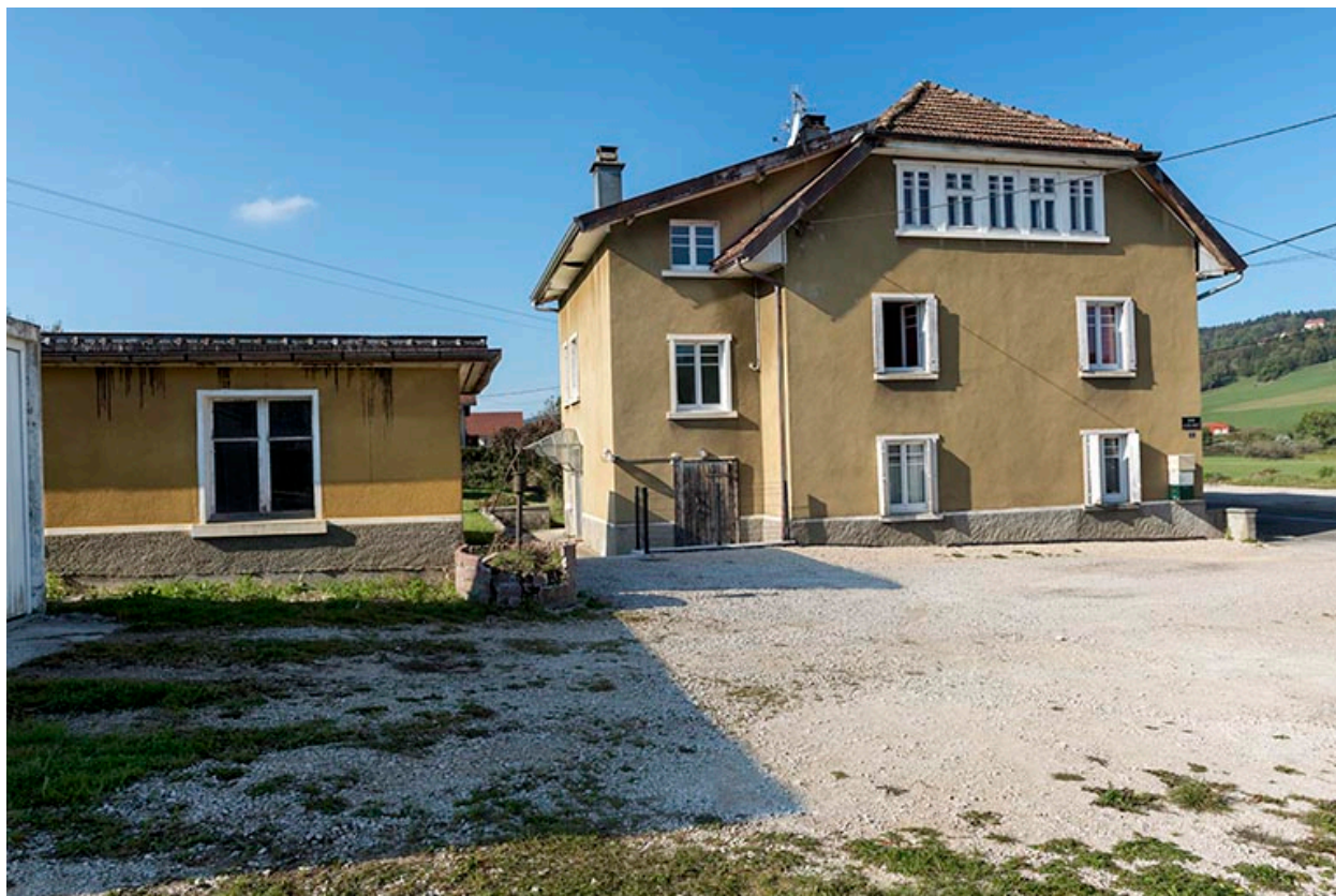
Garage et façade latérale gauche.
