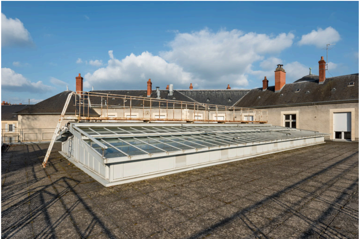
Verrière en toiture du hall du public.
