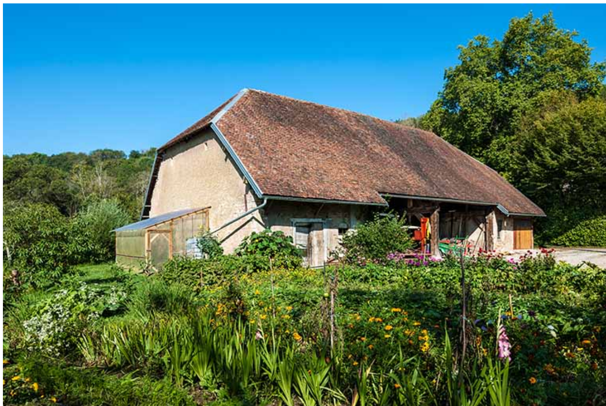
Vue du magasin industriel depuis le sud-est.
