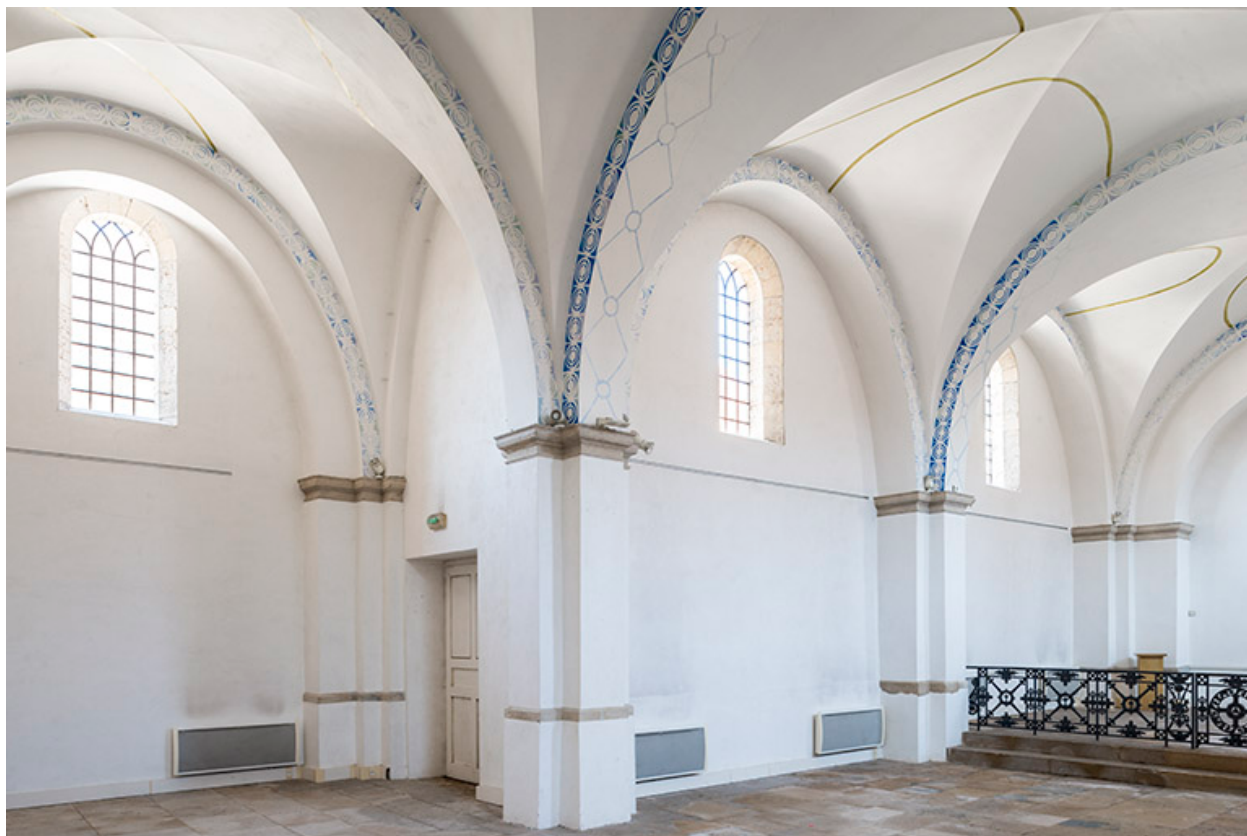
Le mur ouest de la nef.
