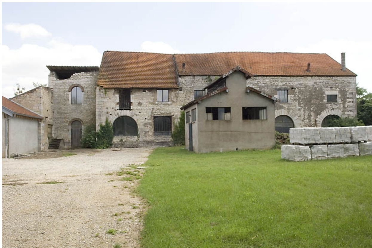
Façade nord du haut fourneau ouest.
