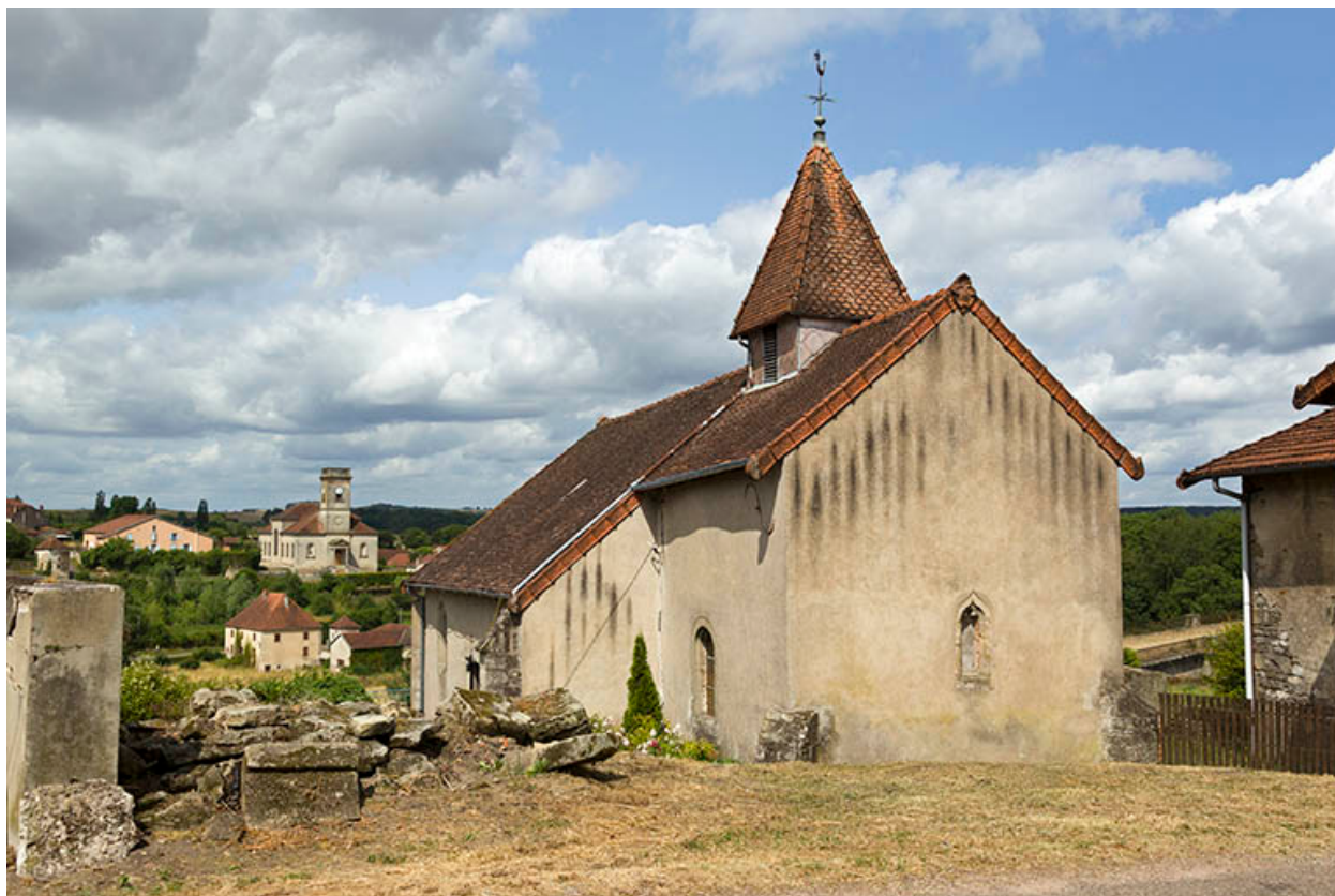
Vue depuis la rue Saint-Antoine.
