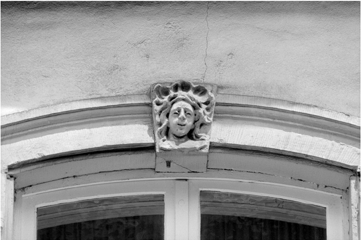
Façade principale, premier étage, détail de la première fenêtre à gauche.
