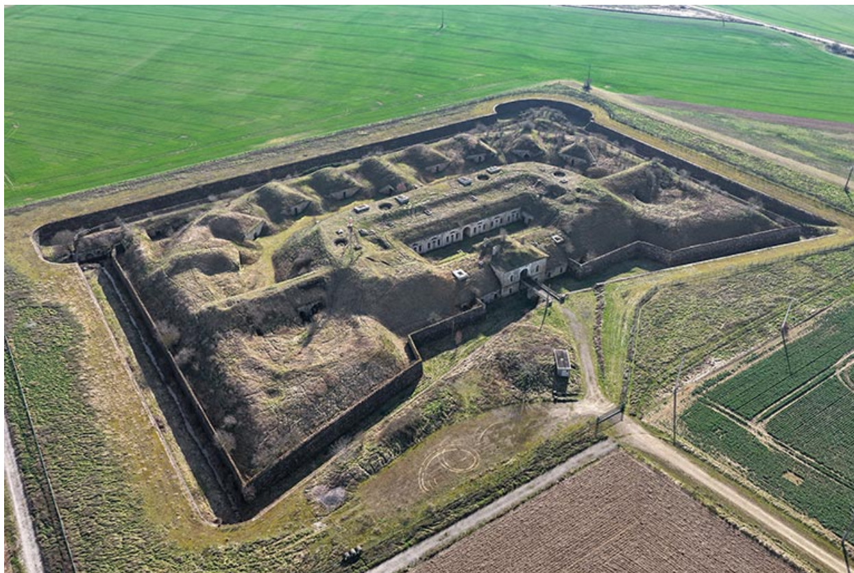
Fort de Beauregard. (vue aérienne).
