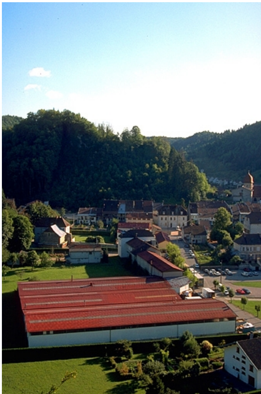
Vue d'ensemble plongeante depuis le nord.
