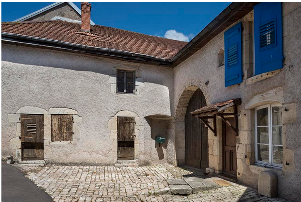
Façade antérieure, partie nord.
