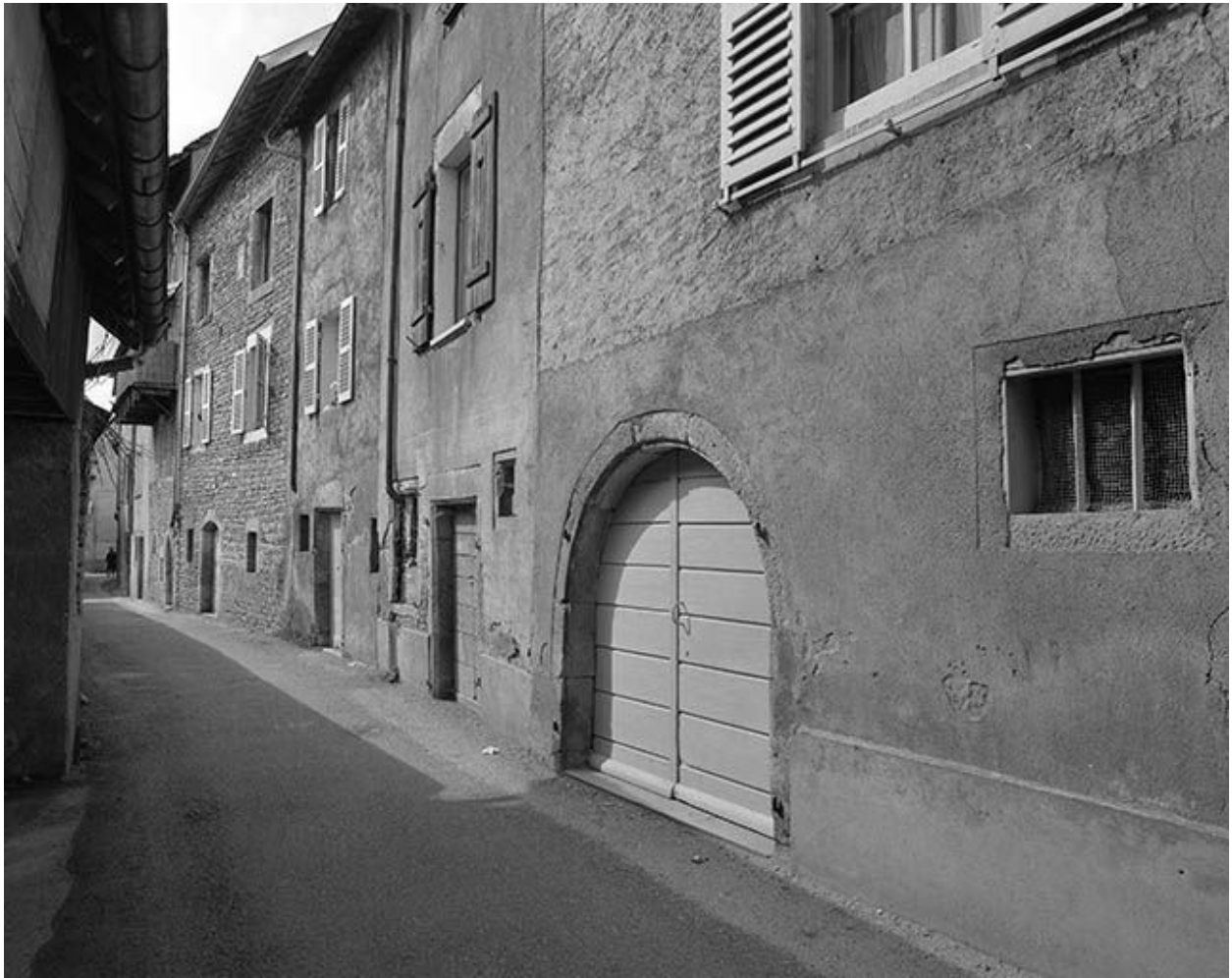
Vue du revers des maisons, côté pair de la rue des Martinets : de gauche à droite 12 à 18.
