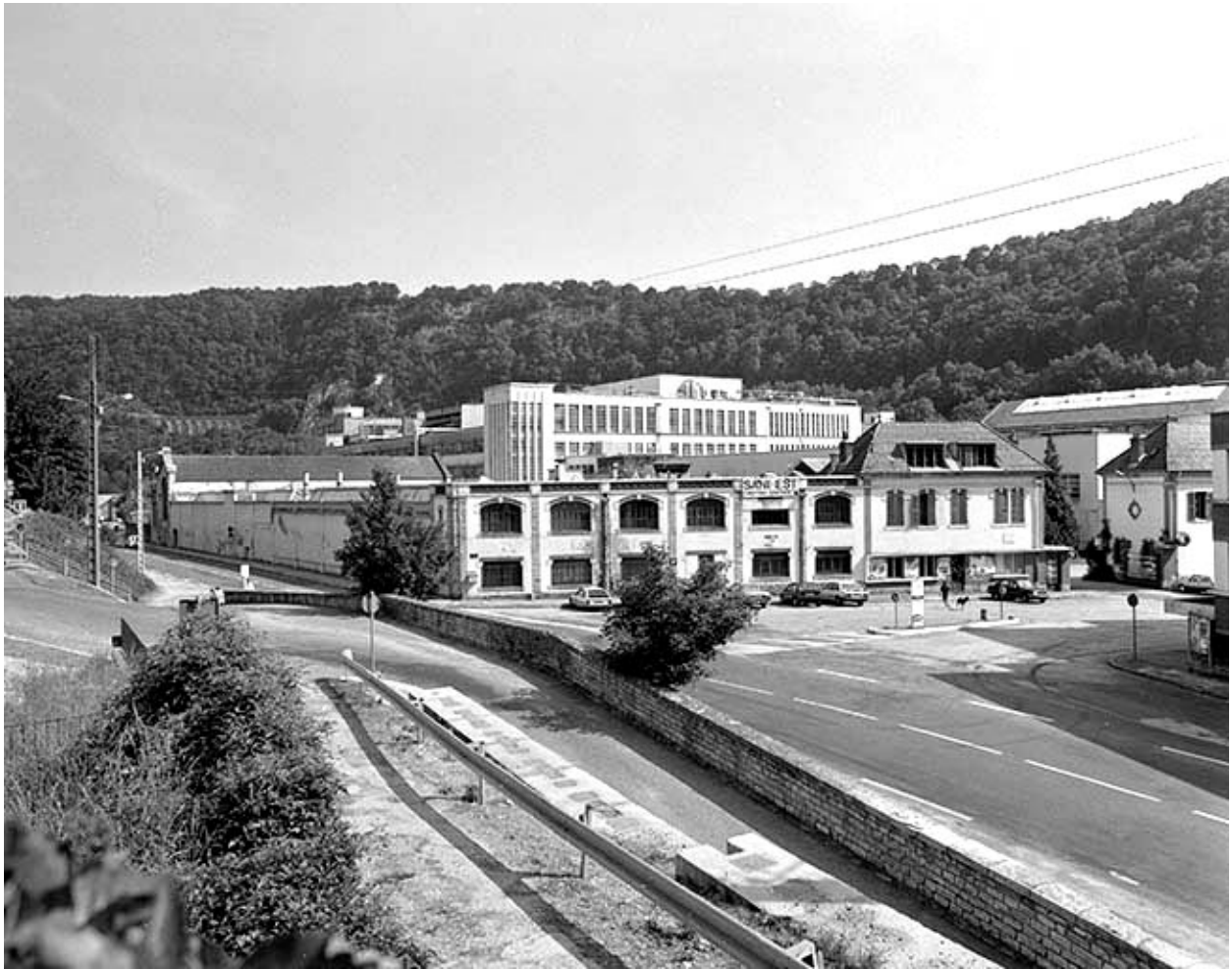
Vue d'ensemble de l'entrée de l'usine A.
