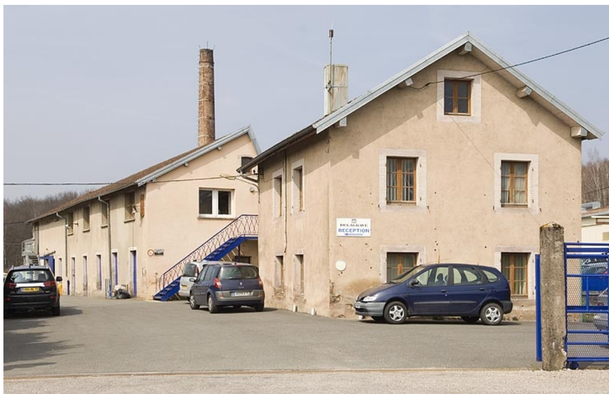
Vue d'ensemble depuis l'entrée.
