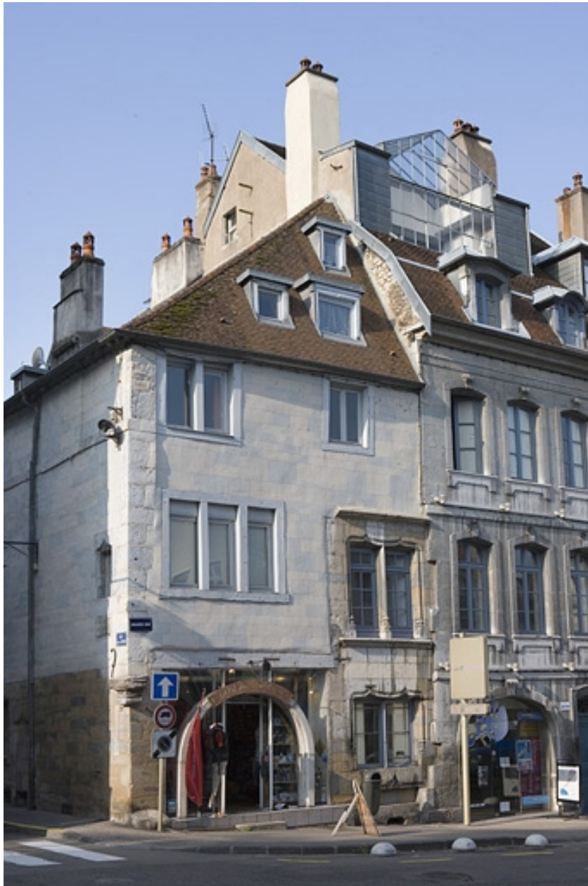
Vue d'ensemble de la façade sur la Grande Rue.
