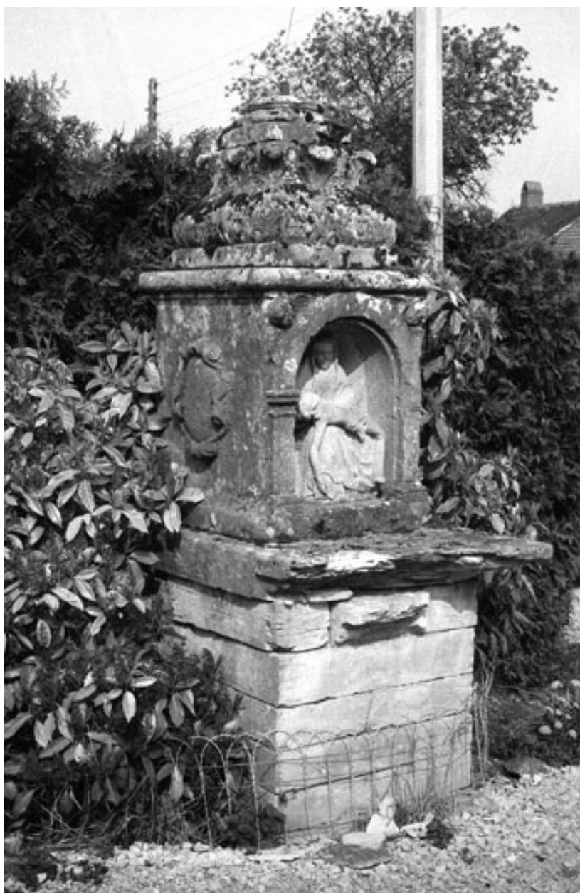
Vue d'ensemble du socle.
