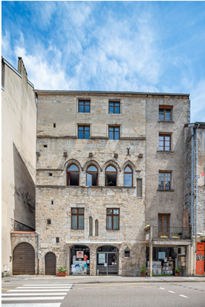
Façade antérieure. Vue de face.
