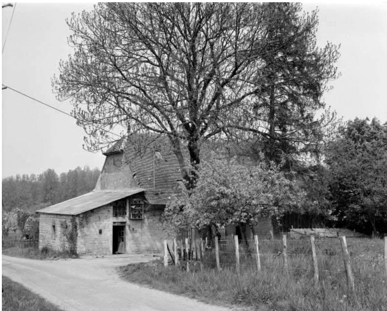
Ferme située 32 rue des Maquisards : vue d'ensemble.
