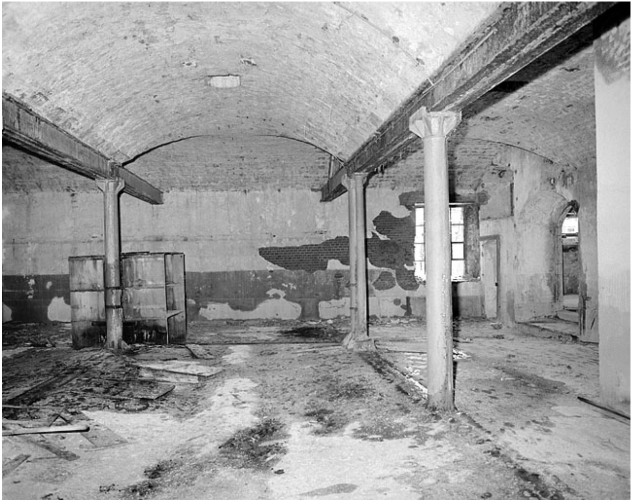
Premier étage, grande salle, côté est.
