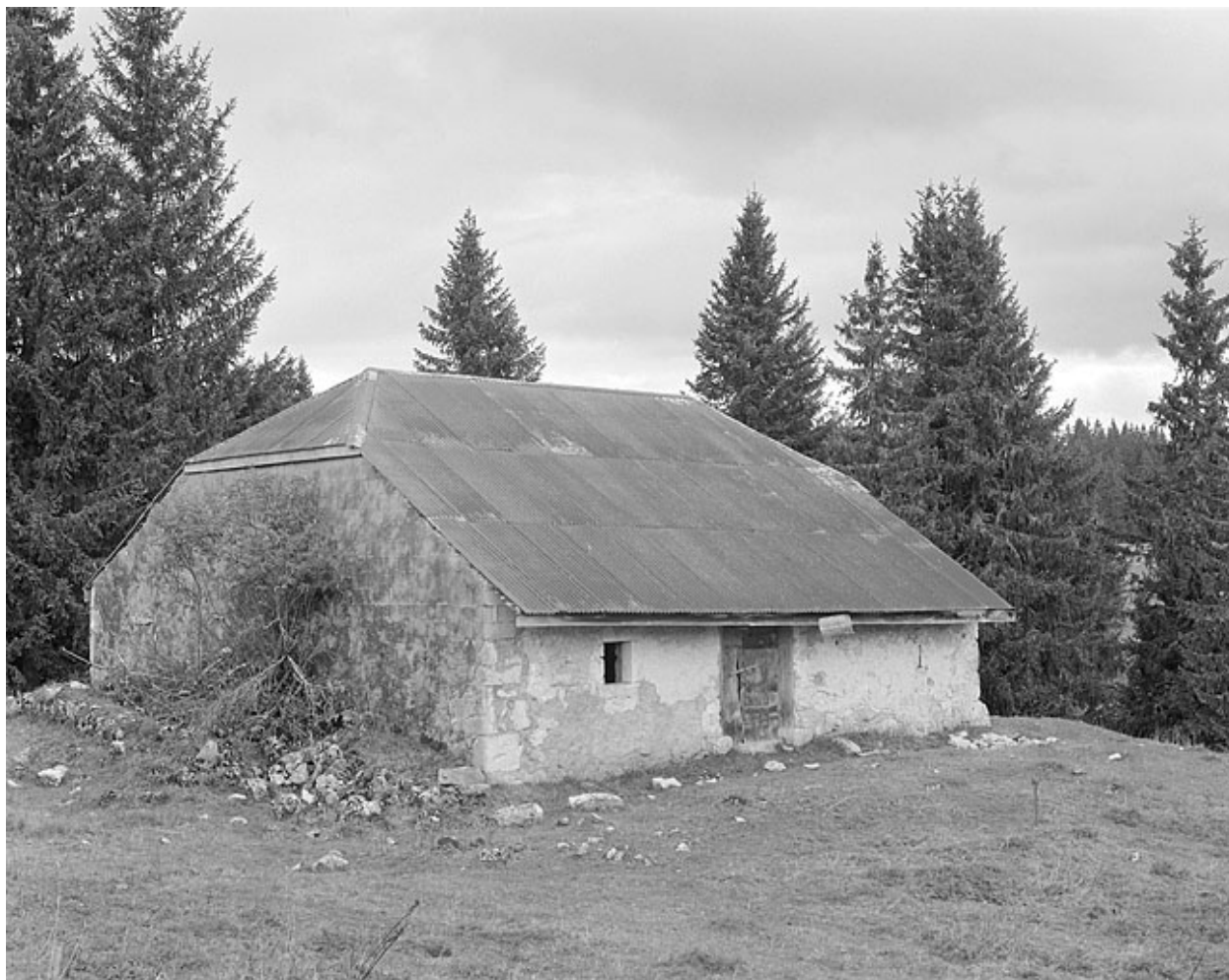
Façade antérieure et face sud-ouest.
