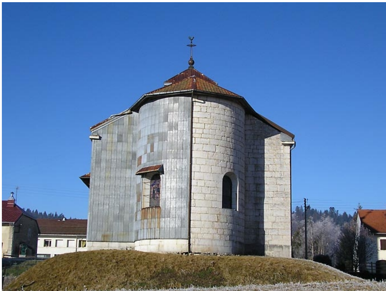
Vue générale de l'abside.
