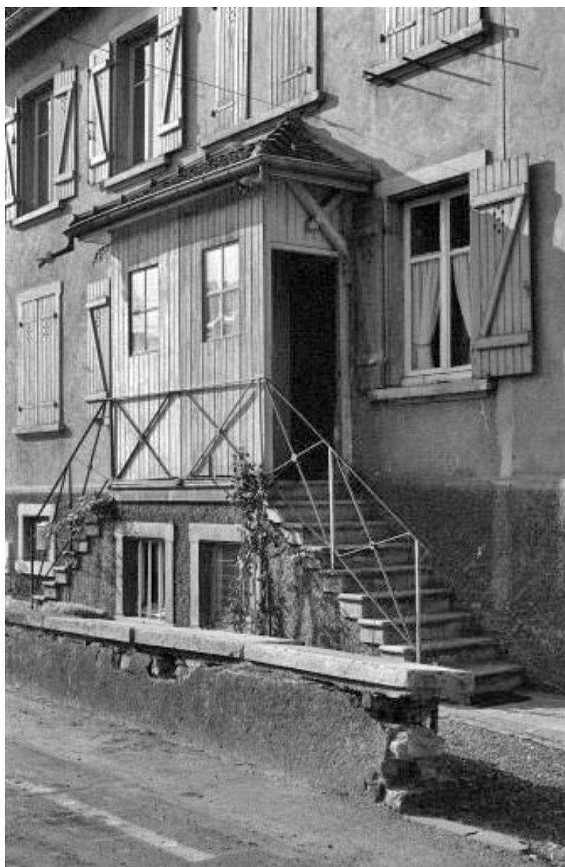
Détail de l'élévation antérieure.
