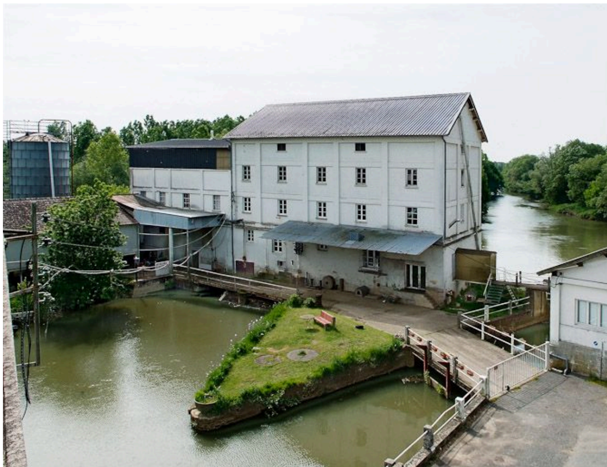
Moulin, bâtiment principal. La Seille de part et d'autre du moulin.
