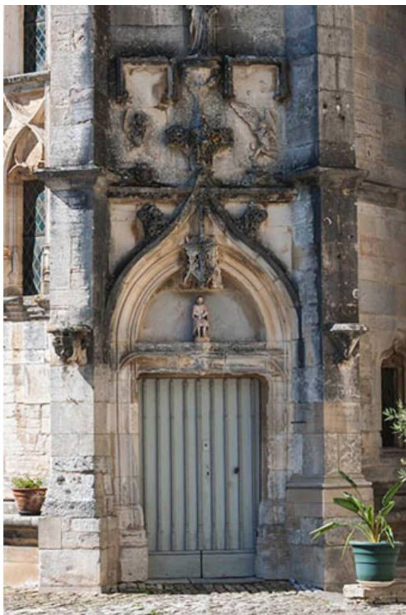
Porte d'entrée de la tour d'escalier
