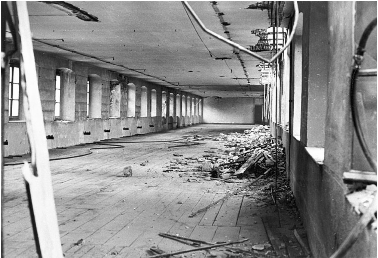
Atelier au second étage (état en 1978).
