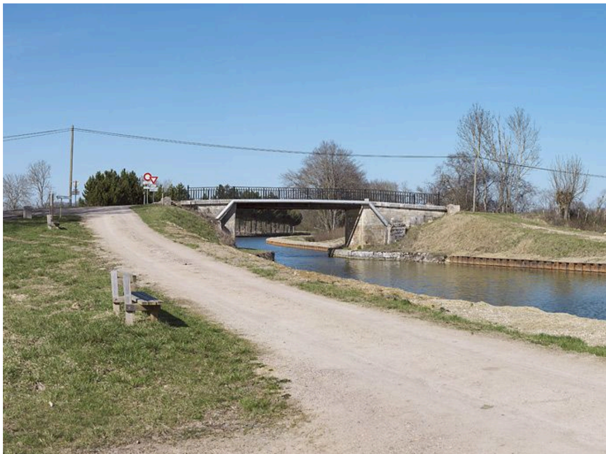
Le pont vu d'amont.
