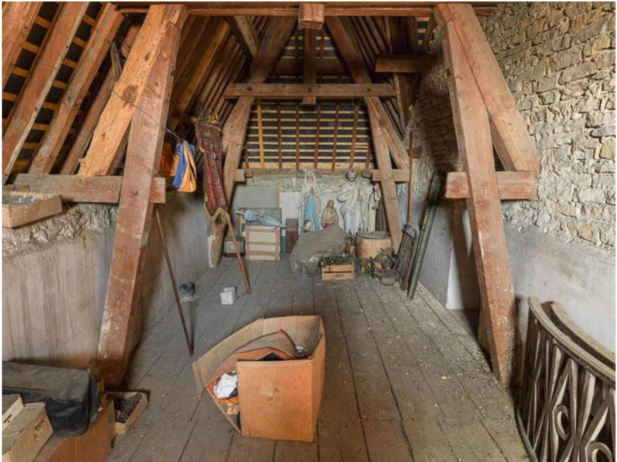
Dépôt d'objets dans les combles de la mairie.
