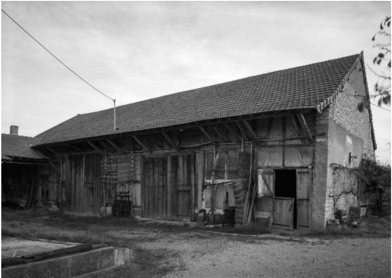
Ferme (cada 1943 C5 557) : bâtiment des dépendances.
