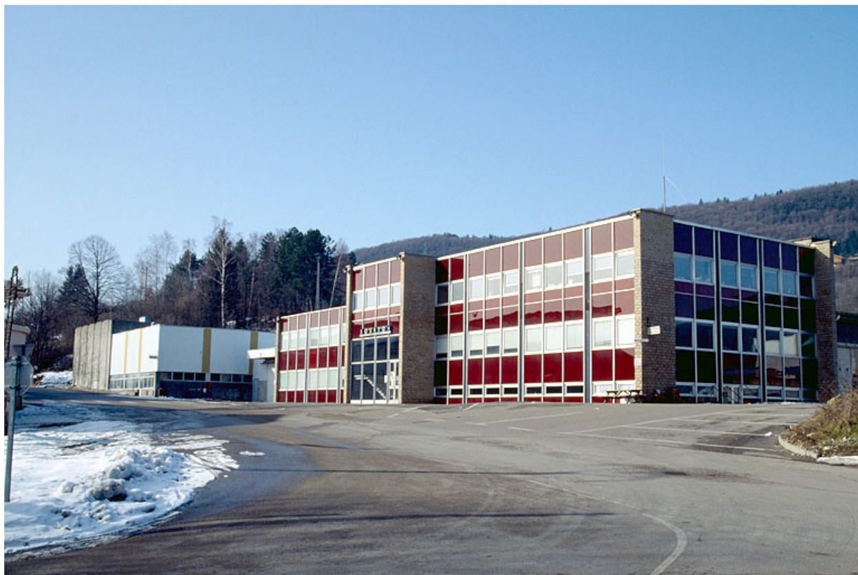
Atelier de fabrication (L) et bureau (O).
