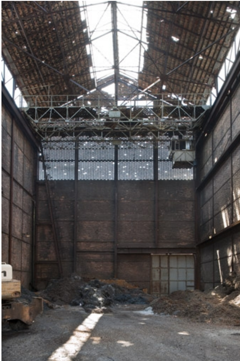
Bâtiment du gazogène. Vue intérieure depuis l'est.
