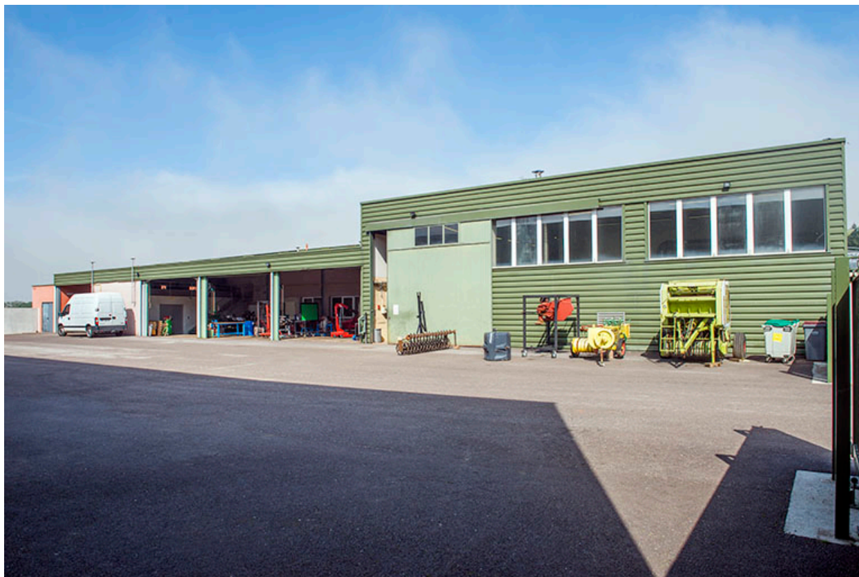
Façade antérieure sud de la halle d'agroéquipement.
