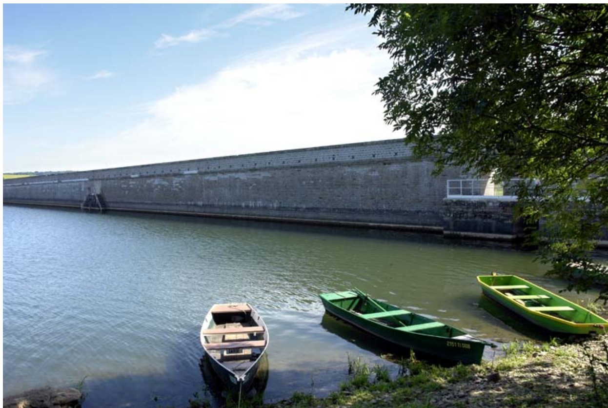
Vue d'ensemble du barrage, face réservoir.
