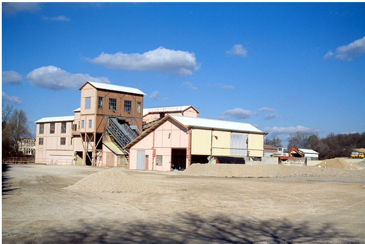
Bâtiments du broyeur vus du sud-ouest.
