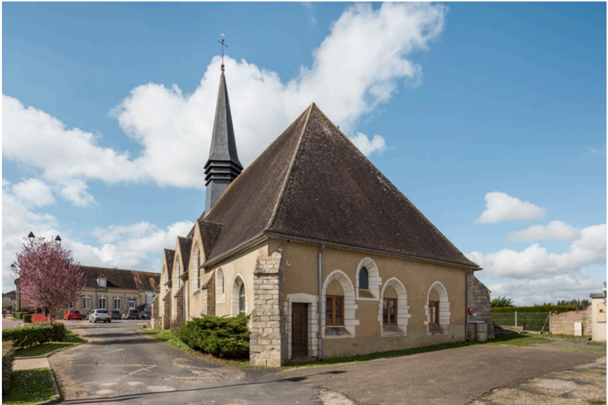
Vue de la sacristie (façade postérieure).
