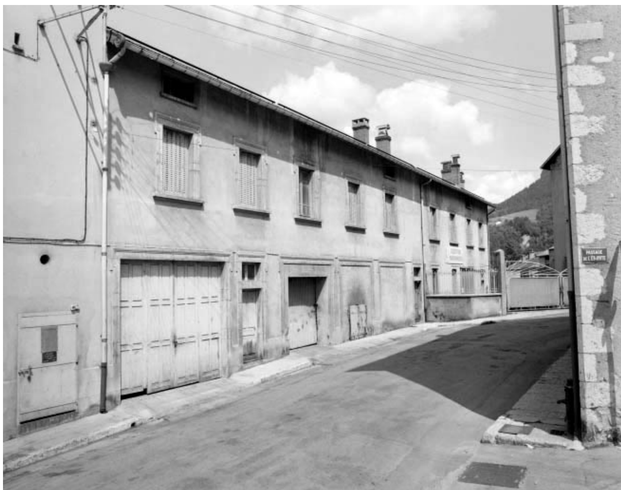
Transformateur, entrepôt industriel et bureau.
