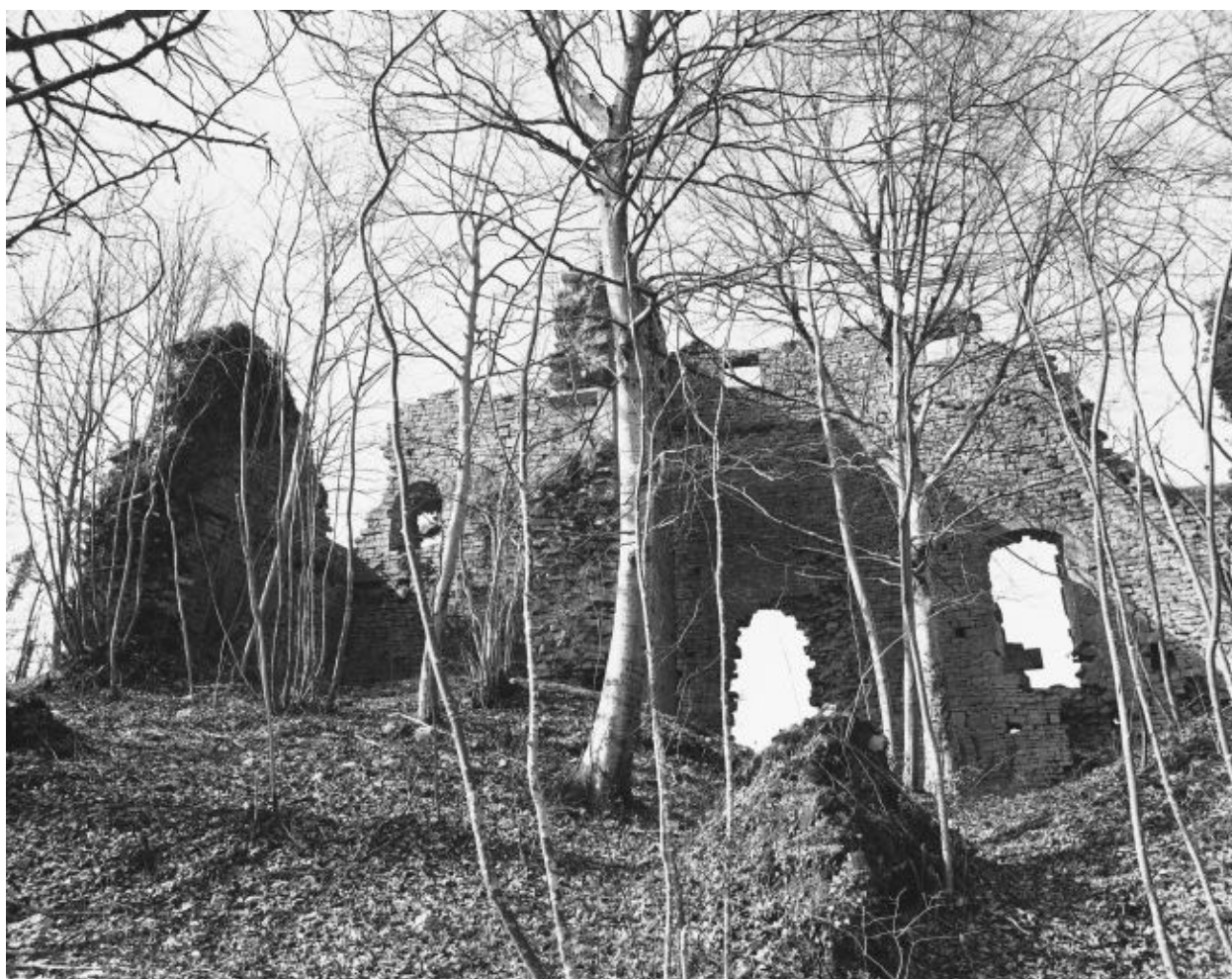
Vue générale des ruines du donjon.
