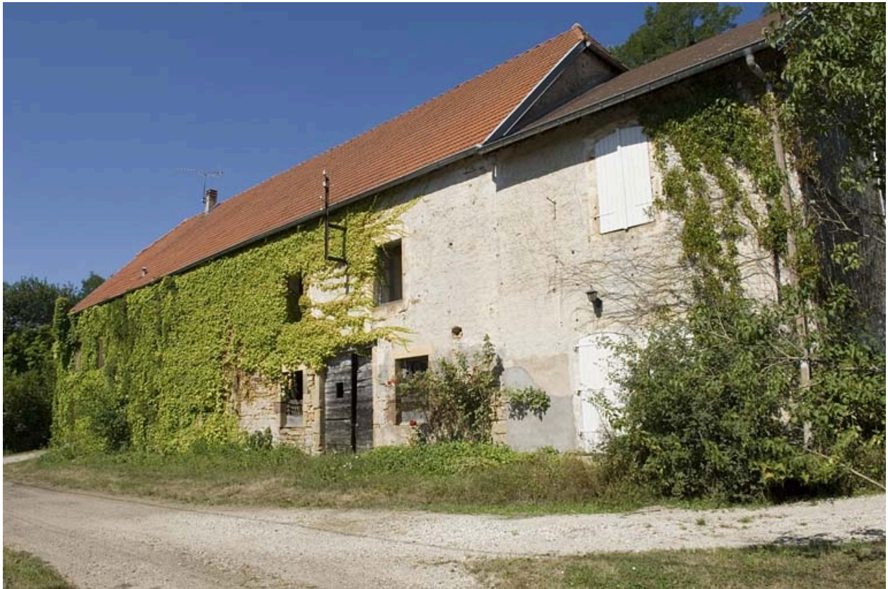
Ancien magasin industriel.
