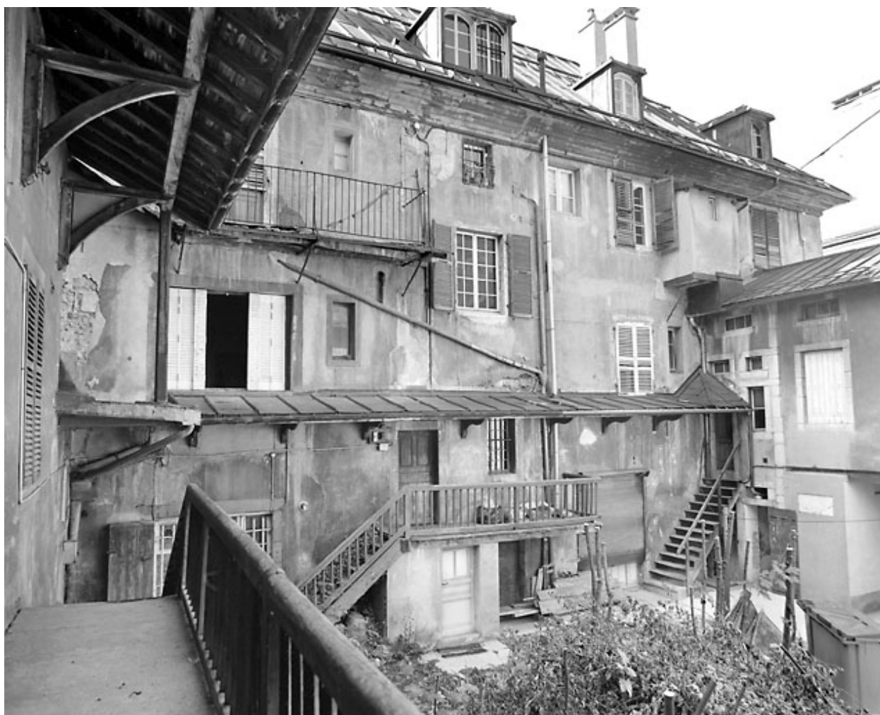
Elévation postérieure, de trois quarts gauche.
