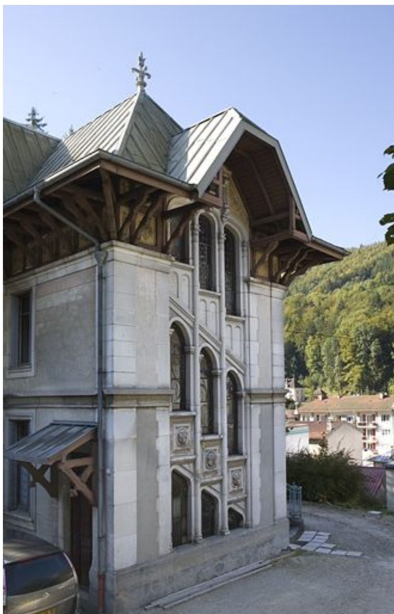
Elévation latérale gauche, de trois quarts gauche.
