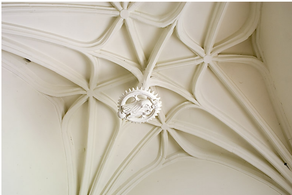
Voûte de la sacristie.
